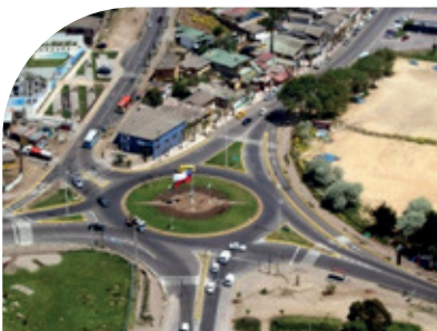
Mejoramiento Ruta F-30, Sector Cementerio Concón – Rotonda Concón
