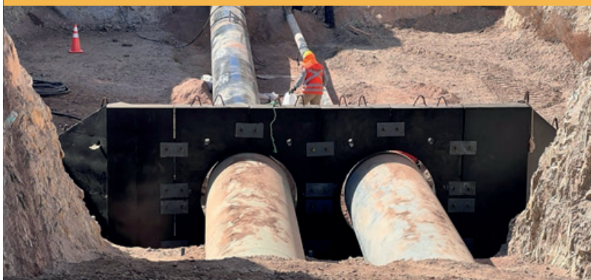
Inspección Técnica de Obra para el Proyecto: "Construcción Muro Boca para empalmar con el Sistema de Transporte de Concentrado de Cobre y Agua desalada (Pipeline)", ubicado en Cruce bajo Ruta 1. Cliente Teck QB2.
